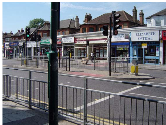
折れ曲がった横断歩道
