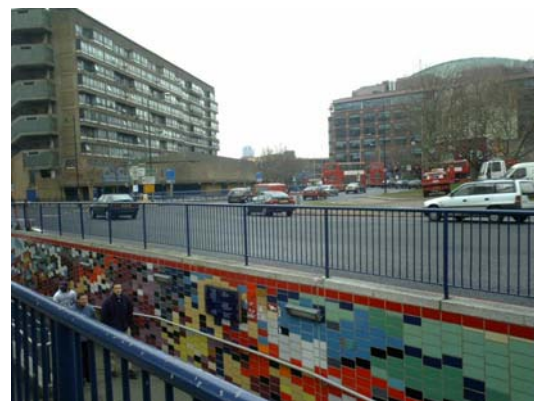
撤去される予定の巨大ラウンドアバウト
